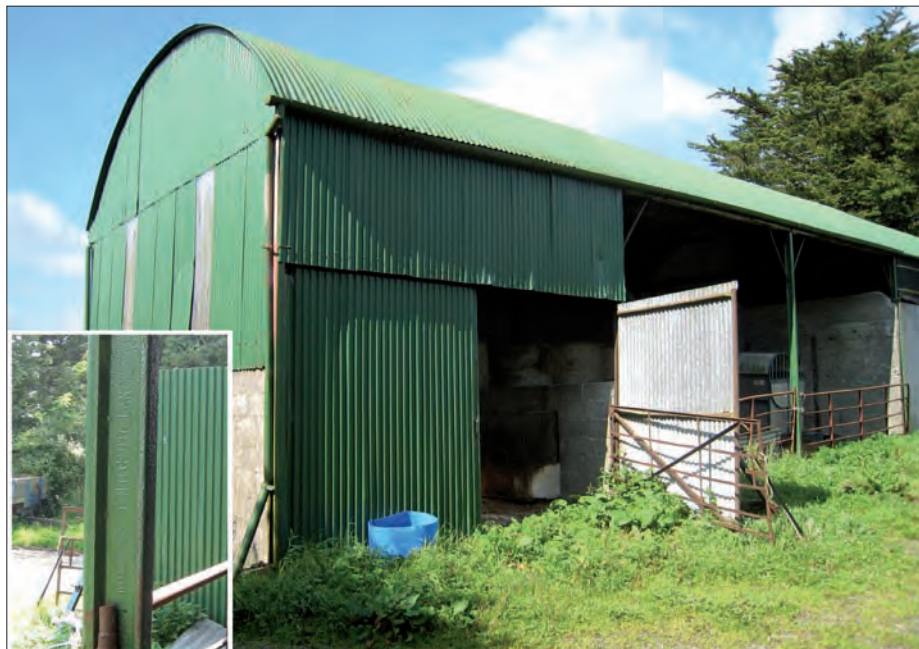
Scioból coitianta ó na 60í i gContae Thiobraid Árann, le fráma de ráillí reatha athúsáidte. Intlis: Tá 'G.N.R.C Ireland' ar an scríbhinn, rud a léiríonn go ndearnadh na ráillí don Great Northern Railway Company.
